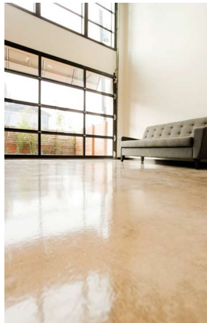
Suelo revestido con microcemento color Sáhara, acabado brillo.
